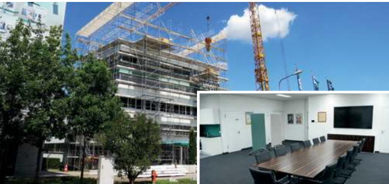
Rénovation de la façade côté sud.
